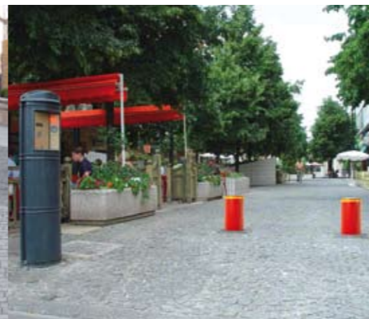
contrôle de l'accès des véhicules
